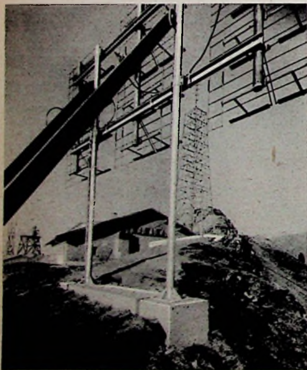
Bild 1. Das Senderhaus auf dem Grünten. Im Vordergrund die Empfangsantenne der Bundespost für die Tonmodulation, im Hintergrund der Antennenturm, allerdings noch ohne Fernseh-Sendeantenne; am linken Bildrand der Empfangsspiegel der Bundespost für die Bildmodulation
